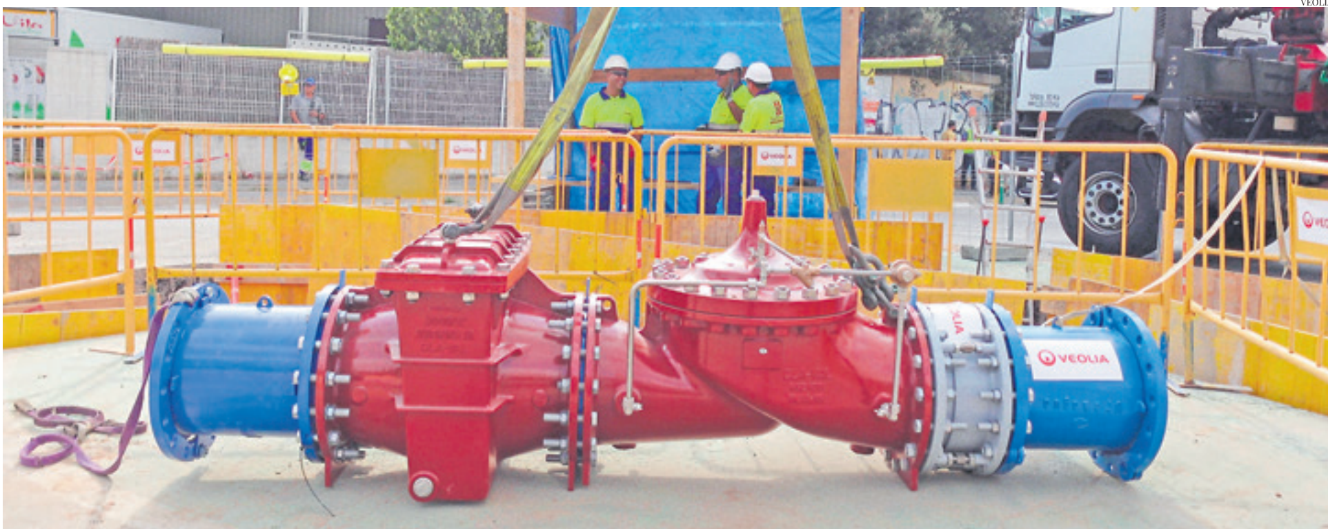
Válvula reguladora de pressions a la xarxa, en el marc del projecte e-READAPTA a Rubí
