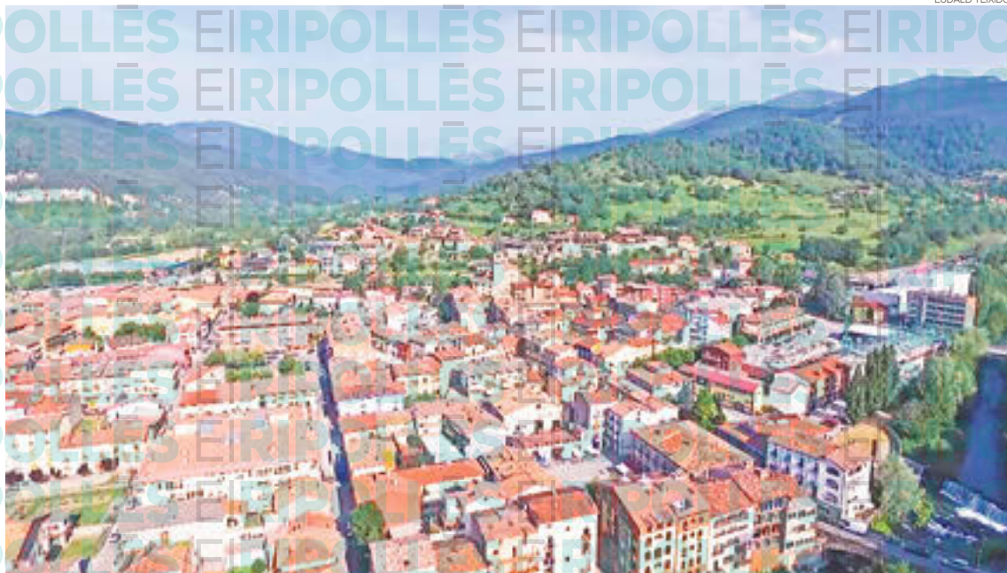
Campdevànol confia en línies d'ajuts per poder impulsar rehabilitacions d'edificis i pisos de particulars al municipi
