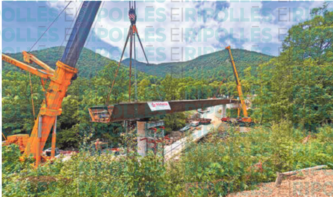
Moment d'hissat del tram central del nou pont del Carbur de Sant Pau de Segúries
