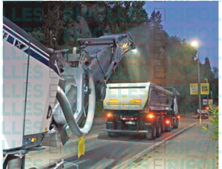
La ronda de Castelladral amb el nou asfalt
