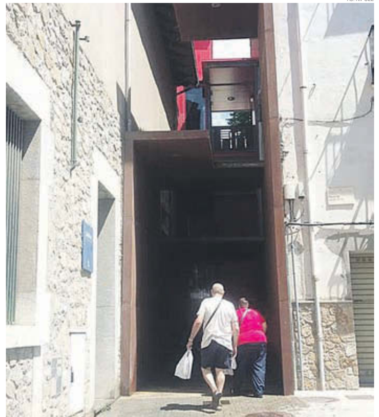
Ja funcionen amb normalitat els dos ascensors que han estat rehabilitats
