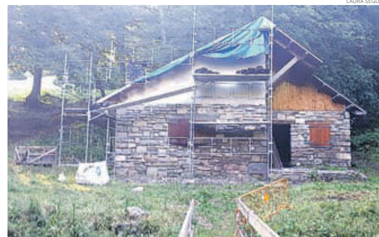
Les obres s'han d'enllestir la propera setmana
