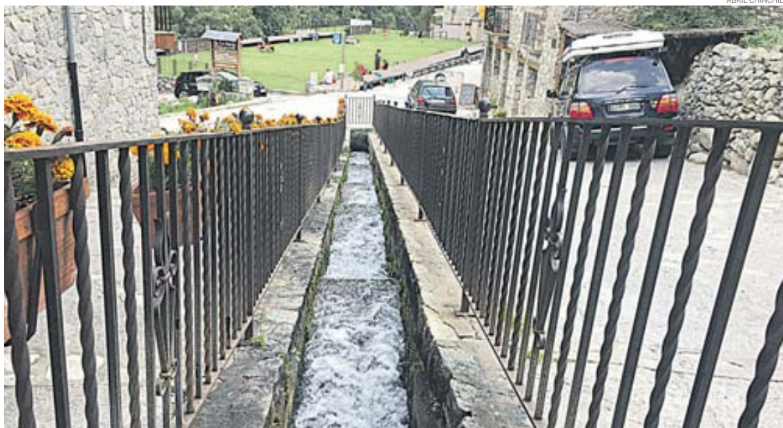
L'estudi servirà per saber l'estat de les canonades de la vila i millorar la pressió de l'aigua
