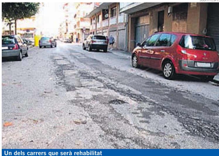
Un dels carrers que serà rehabilitat
