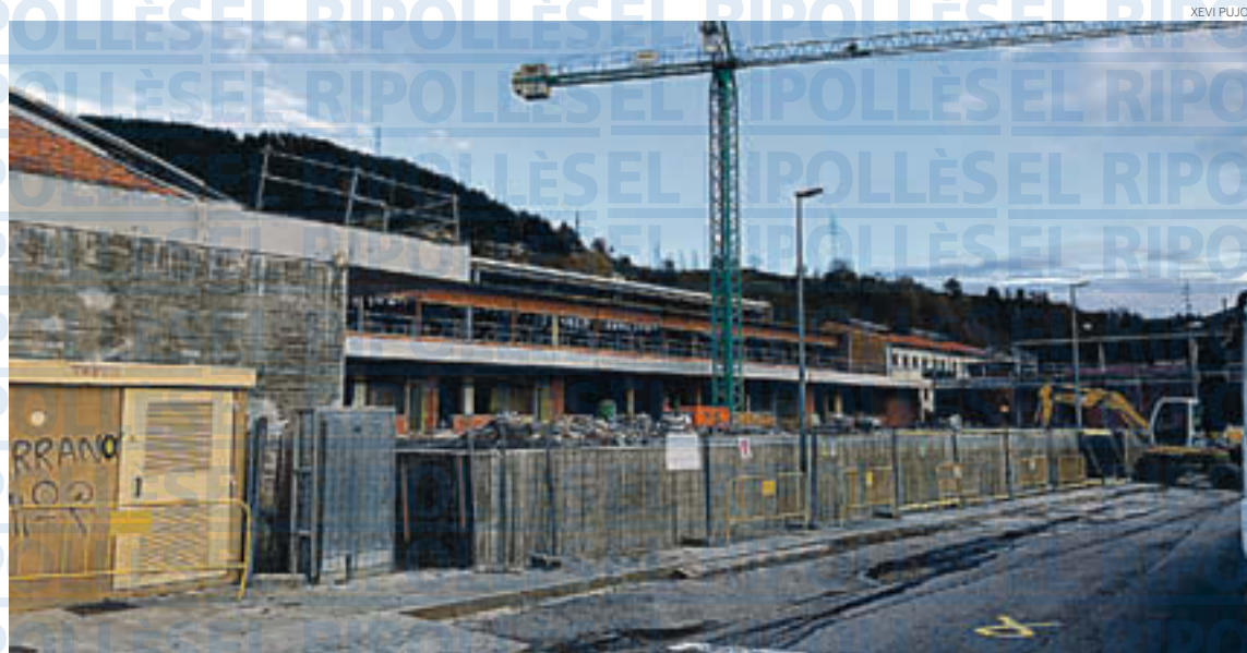
L'estat actual de les obres del nou centre a la zona de Can Ribalaigua
