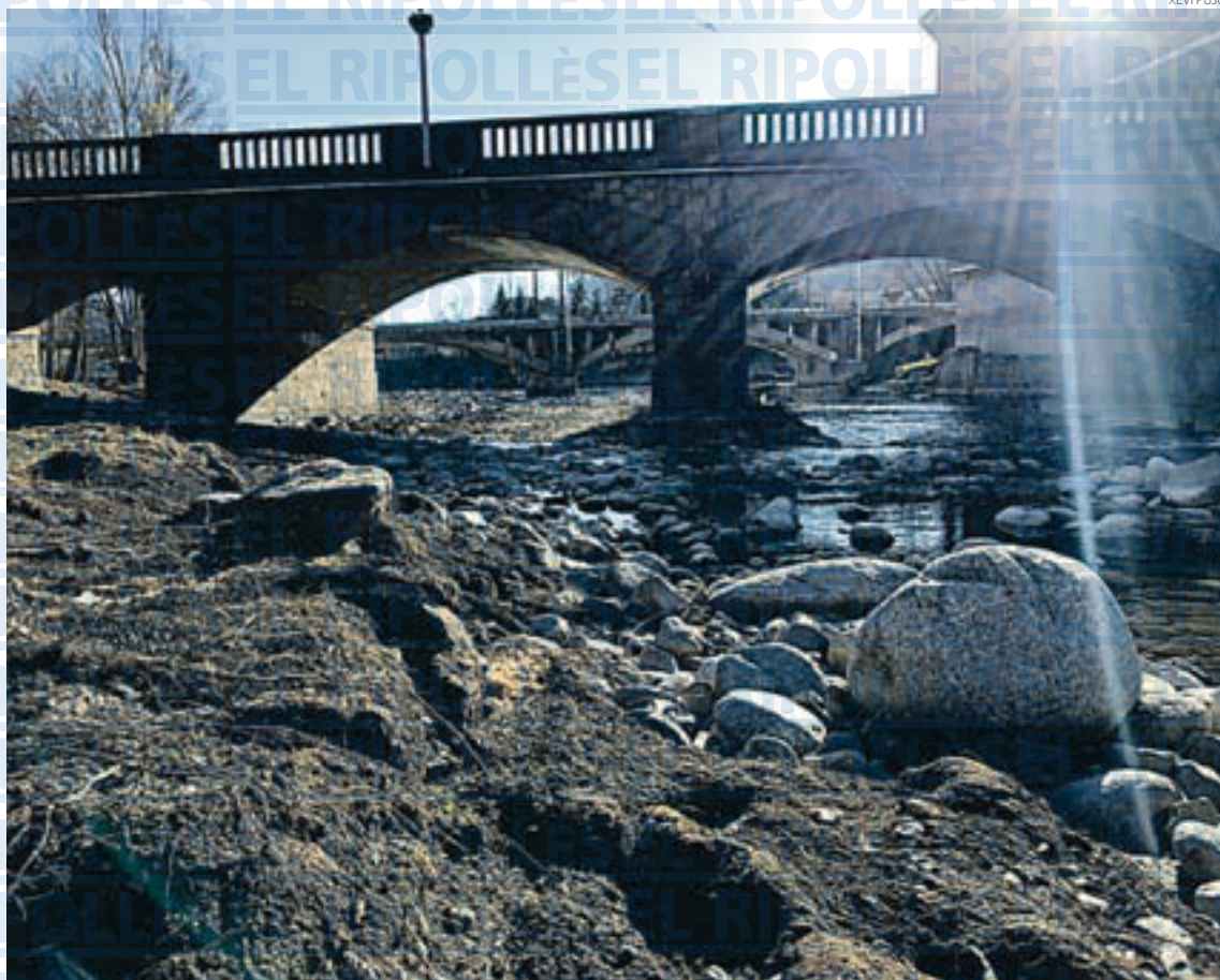
Els treballs a les lleres dels rius van avançant, però no s'enllestiran fins d'aquí a uns tres mesos
