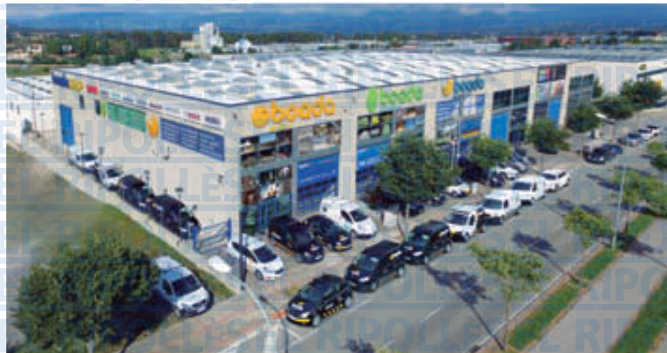
Vistes de les naus amb el Showroom de 1.500 m², al carrer Francesc Santcliment, 57, de Vic
