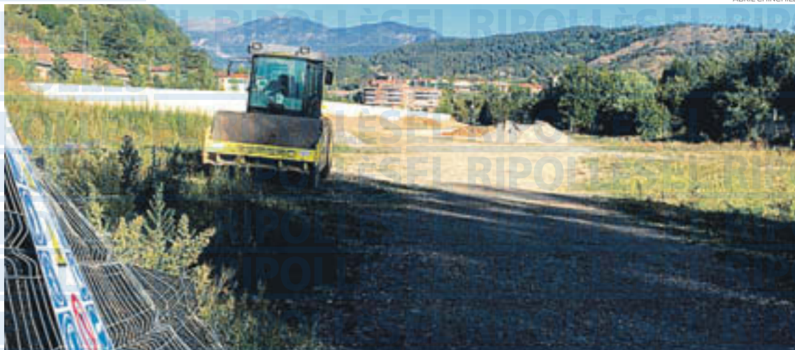
Les obres d'adequació del Pla engeguen motors per fer realitat la zona verda
