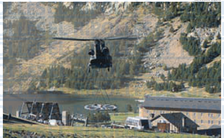
Trasllat dels volants de l'estructura amb l'helicòpter de doble hèlix
