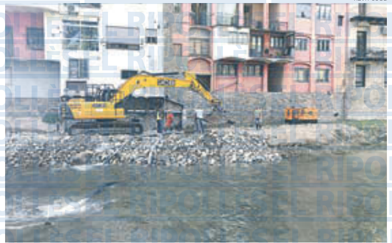
Treballs a la llera del Ter per reparar el col·lector situat en aquest punt de Ripoll
