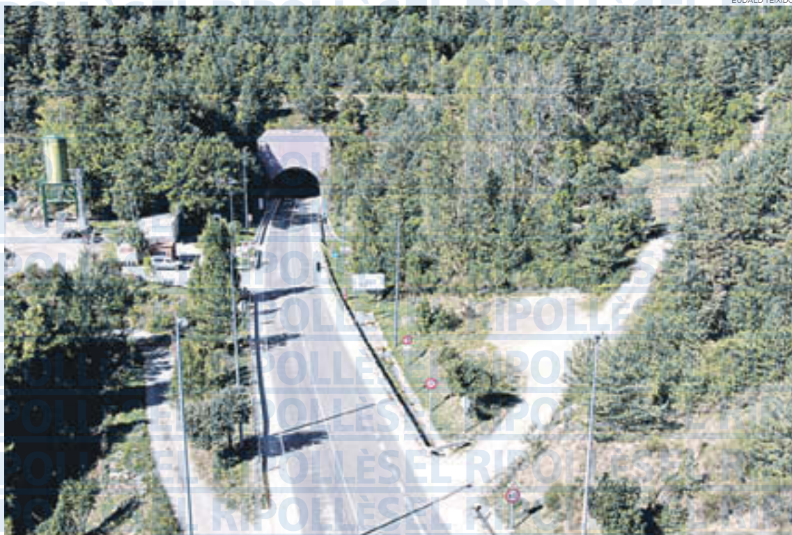
L'entrada de la banda garrotxina del túnel de Collabós
