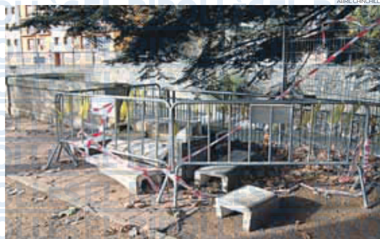
Les actuacions tindran una durada aproximada de tres setmanes
