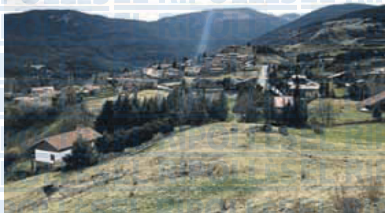
La depuradora de Campelles tindrà una capacitat petita
