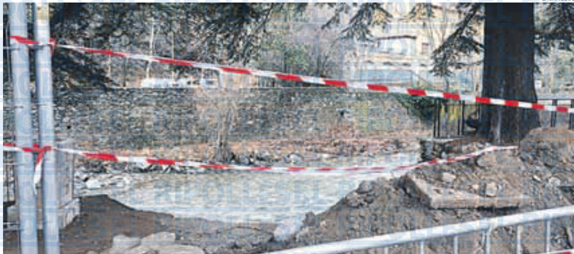
Ja s'ha executat la primera fase d'arranjament del mur del passeig Guimerà
