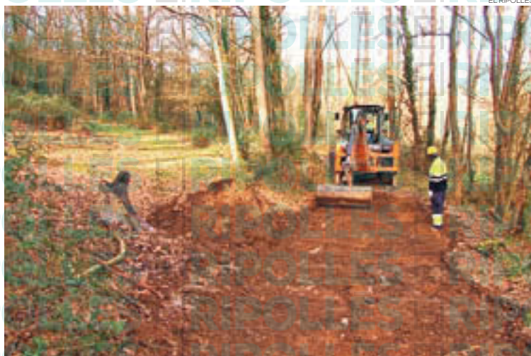
Inici de les obres a la Vall de Bianya
