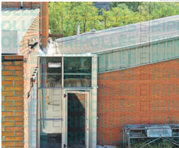
El problema dels degoters venia de la canalera que dona al passadís dels vestidors
