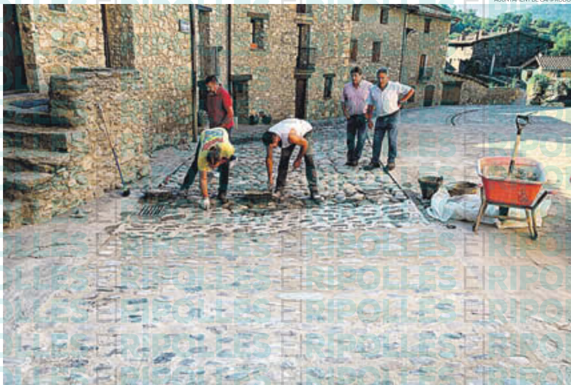
Les obres al terme de Beget es troben en les darreres fases
