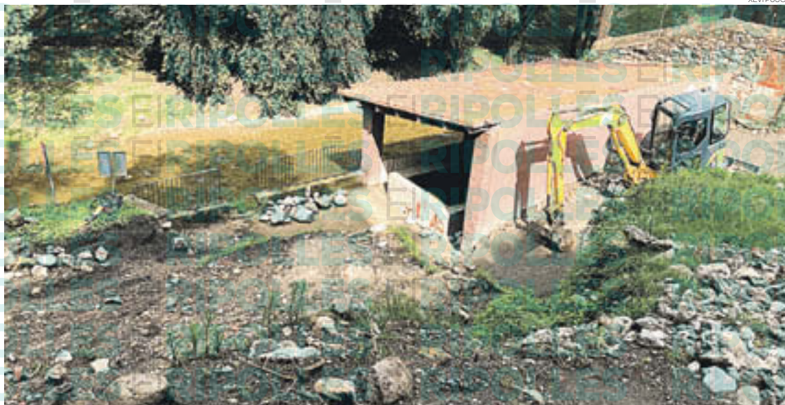
Les obres que ja s'estan executant tenen un cost de més de 180.000 euros i volen connectar el poble amb l'Arçamala en aquest punt
