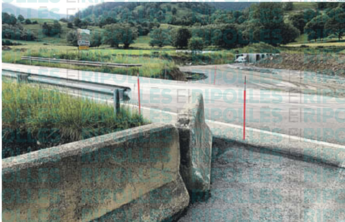
Les obres de construcció de la rotonda són complexes per la quantitat de serveis que hi ha
