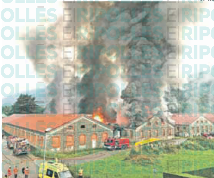
El sostre va col·lapsar i es va ensorrar totalment
