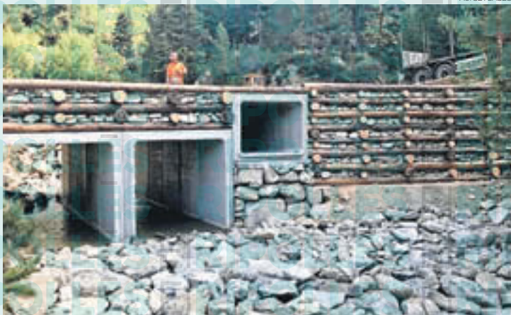
Obres de construcció del pont al torrent de Carboners
