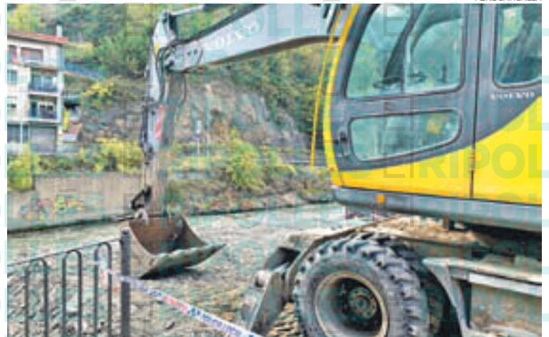
Màquines treballant al tram del Freser a l'entrada sud de Ribes
