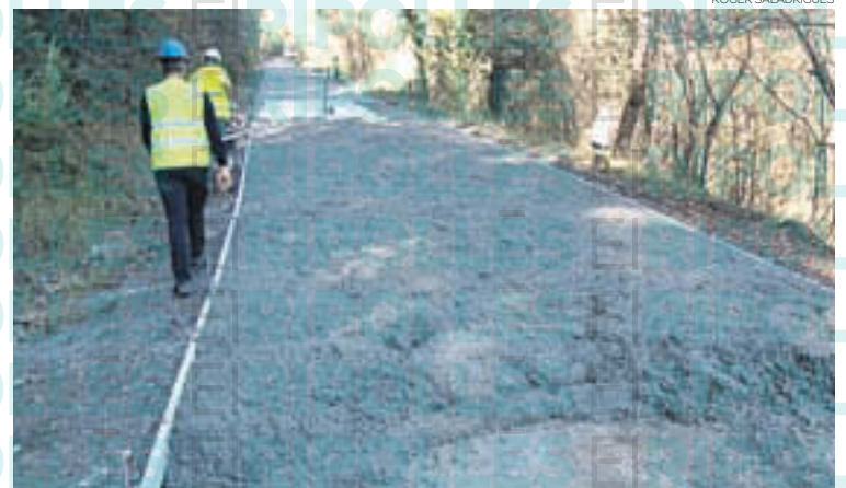
Les obres al camí de Ribamala
