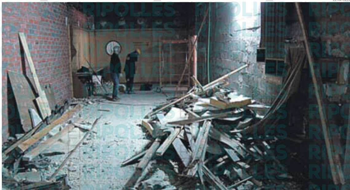
S'ha començat a actuar per arranjar l'espai i adequar-lo a les necessitats actuals
