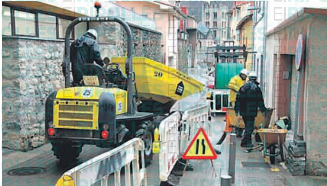
La instal·lació de fibra òptica aprofitant la nova via verda és condició del conveni entre la Diputació i la Generalitat
