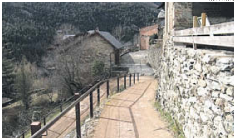
Una de les actuacions s'executarà al carrer de Baix
