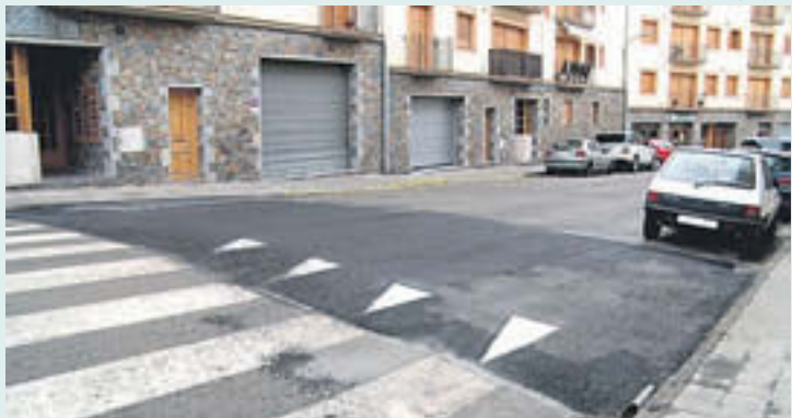
Una de les bandes reductores instal·lada recentment
