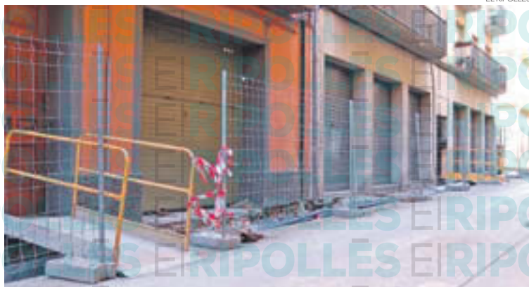
La reforma del carrer Fonderia que Ribes de Freser culminarà en les pròximes setmanes
