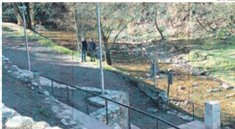
Estat actual de l'espai amb la finalització d'una de les fases d'actuació
