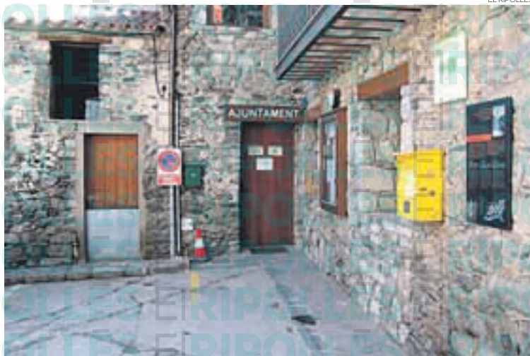
Actualment la instal·lació precisa d'algunes actuacions d'adequació
