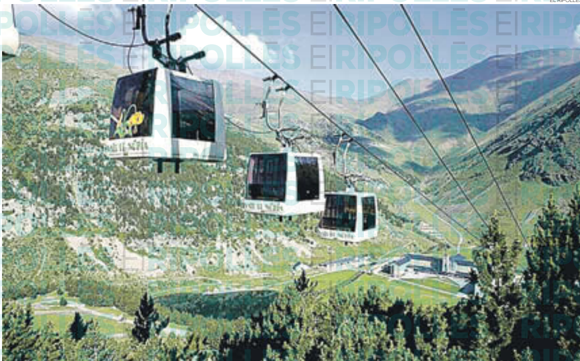
A Vall de Núria, Queralbs, s'ha retirat la ferralla derivada de la substitució del telecabina Coma del Clot
