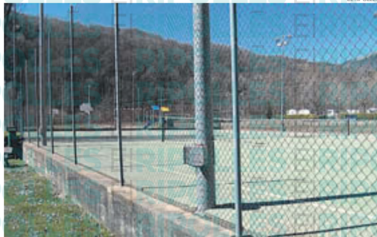
Estat actual de la pista poliesportiva de Vilallonga de Ter
