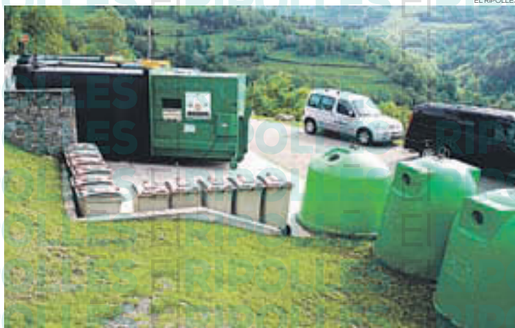
Es col·locarà una tanca i s'instal·laran càmeres de vídeo vigilància als compactadors
