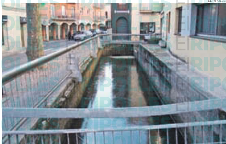
L'estat actual del canal a l'espera dels treballs per recuperar l'aigua
