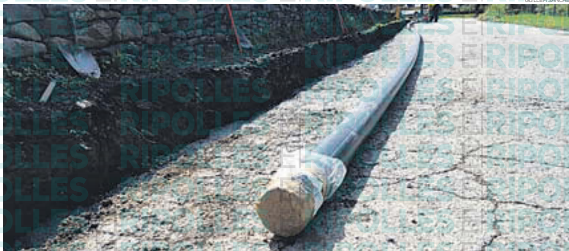
Els treballs s'estan duent a terme des del pont de la Plana en direcció al camí del veïnat de Feitús
