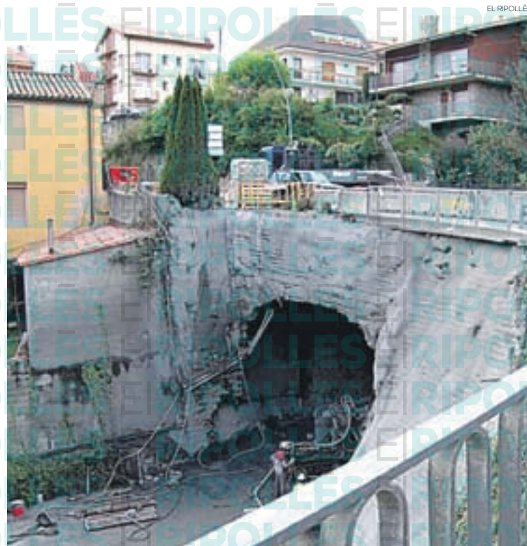
Les obres a la N-260 al seu pas pel pont d'Oganes, a Sant Joan de les Abadesses
