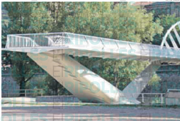
Estat actual del pont després del primer bloc d'actuacions
