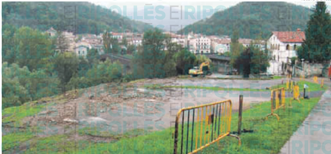
L'execució de les obres està previst que duri uns nou mesos
