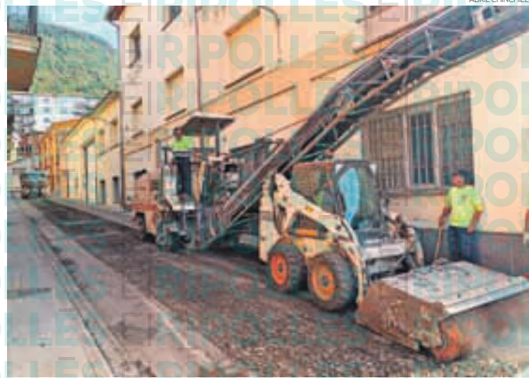
Els operaris treballen en l'asfaltatge dels carrers
