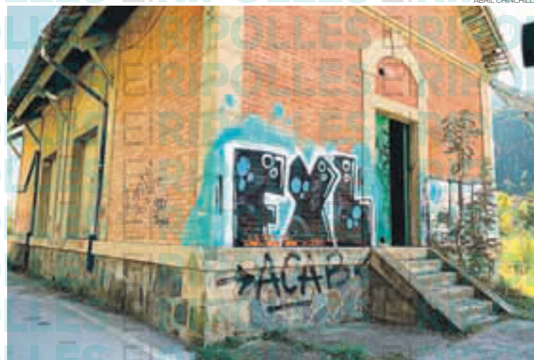
L'edifici a enderrocar era un antic magatzem propietat d'Adif
