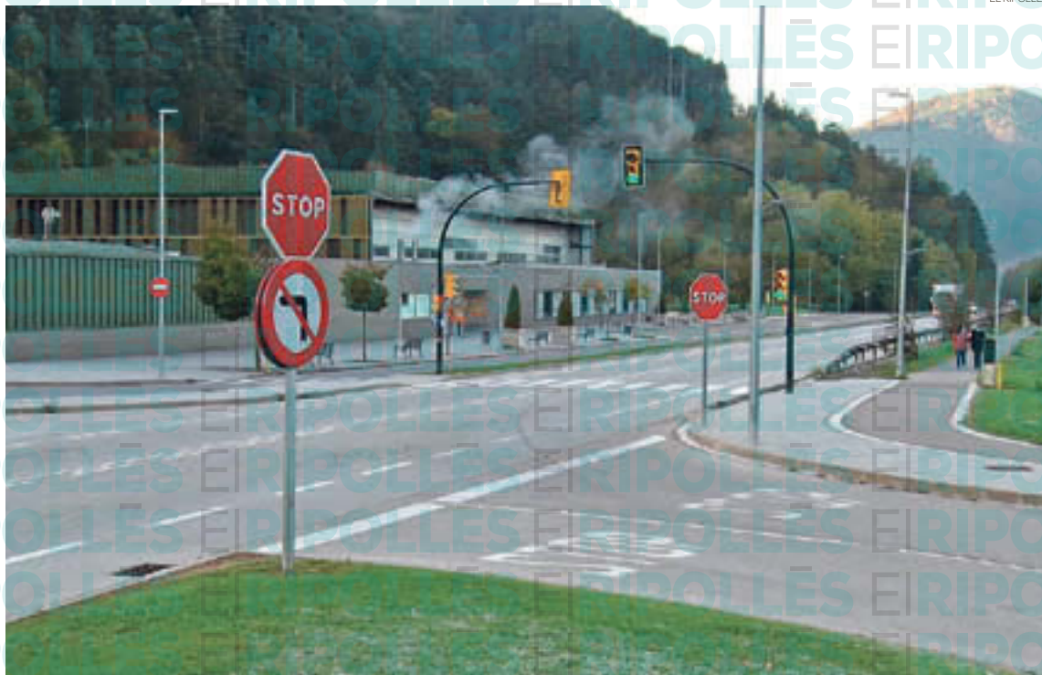
Estat actual del tram a Ripoll, a l'espera de les rotondes com a mesura de pacificació del trànsit i millora de la seguretat
