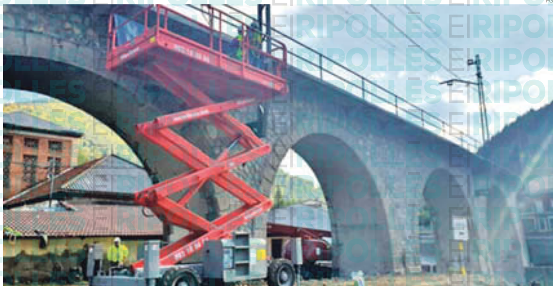
Inici de les obres al pont Can Gusi del Cremallera de Núria
