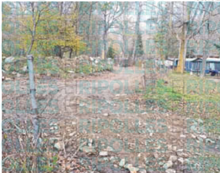
L'ajuntament assegura que el mur de contenció s'enllestirà en els pròxims mesos
