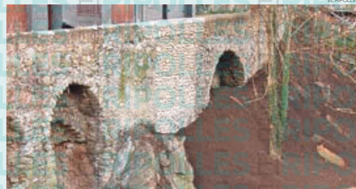
Les obres han permès la consolidació de les bases dels murs per evitar esfondraments
