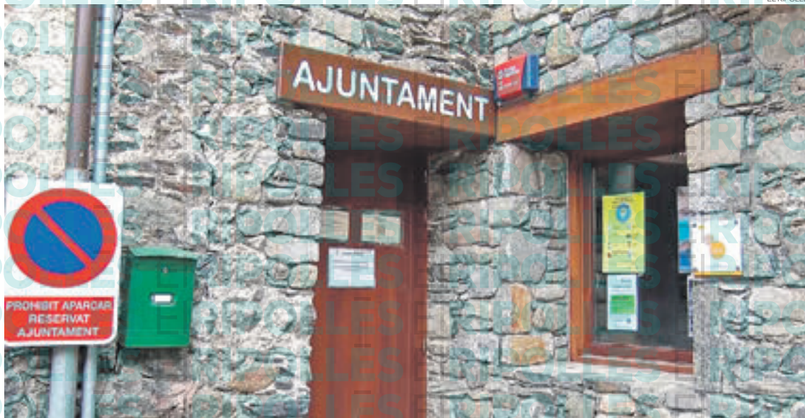
Exterior de la façana de l'Ajuntament de Setcases
