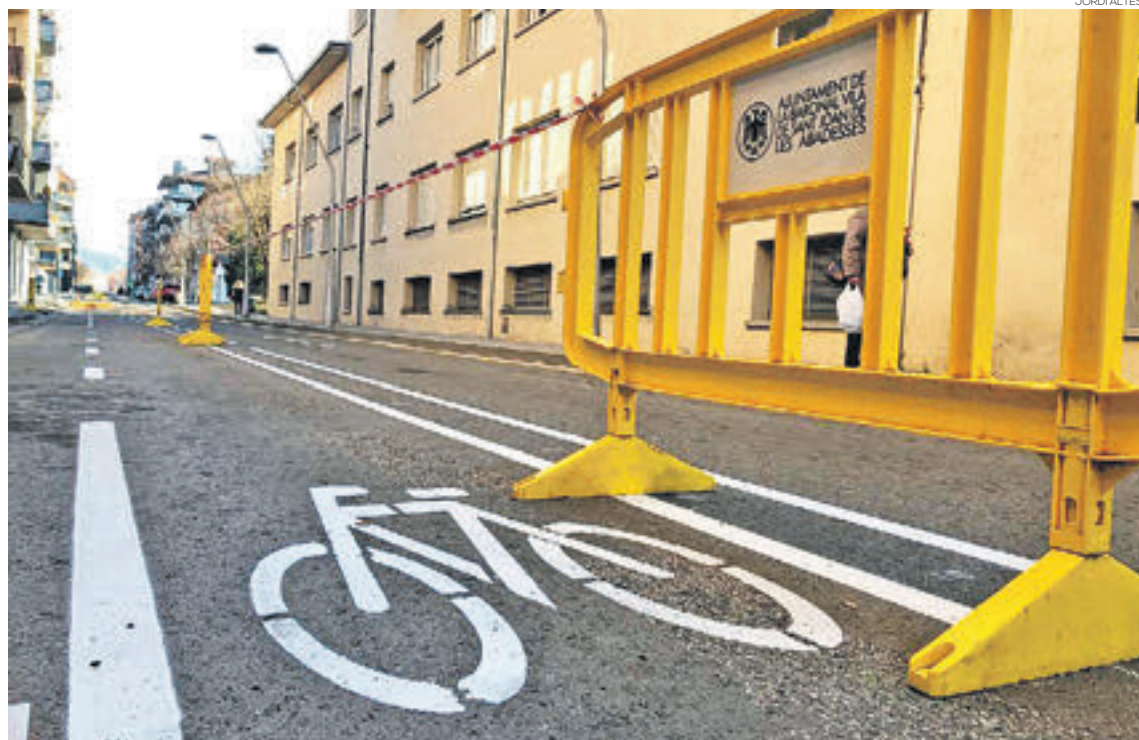
Les obres que s'estan fent aquests dies al carrer Ramon d'Urg de Sant Joan de les Abadesses
