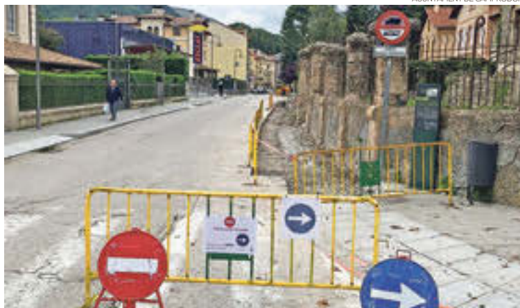
Tram en obres del carrer Freixenet
