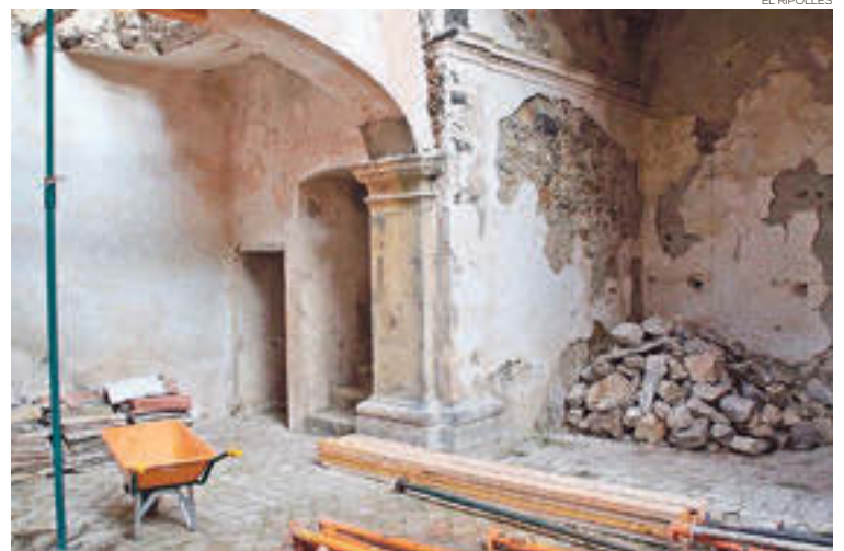
Rehabilitació de la teulada amb la consolidació dels arcs
