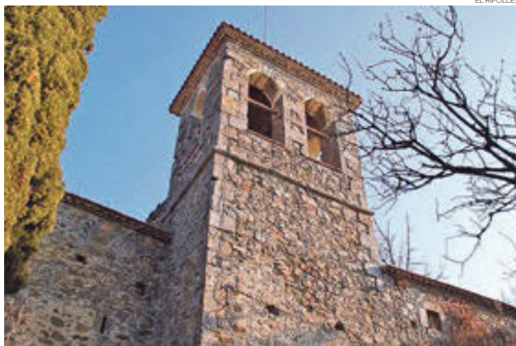
Estat actual de l'església de Sant Cristòfol durant la tercera fase de les obres
