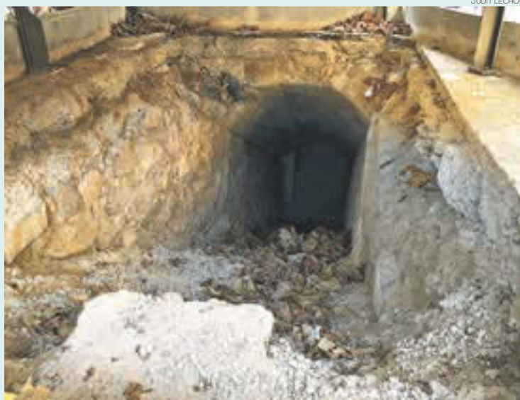
Entrada del refugi antiaeri de Ripoll, situat a la plaça de l'Ajuntament
