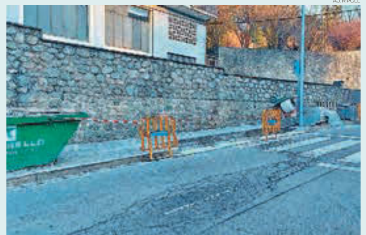
Una de les voreres que s'arregla a la carretera d'Olot
