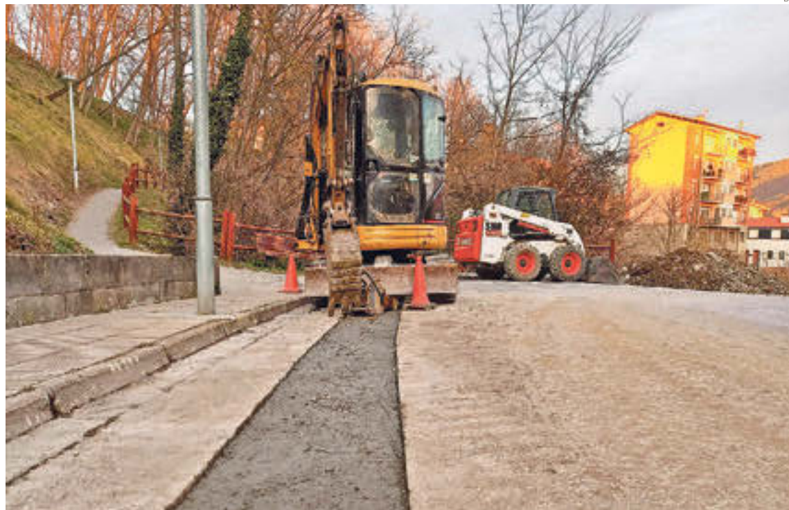
Tram del carrer Sant Jordi afectat per les obres
