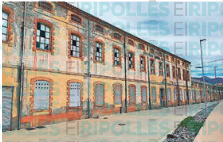
El projecte preveu rehabilitar els 67 immobles de la Colònia Llaudet
