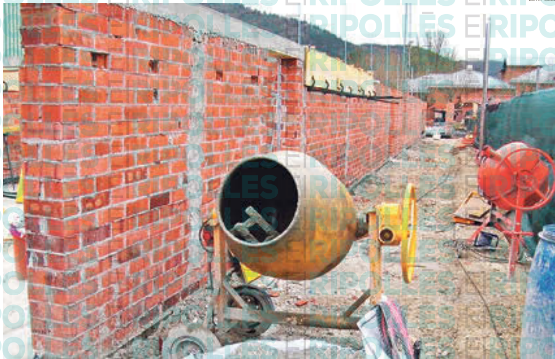
L'obra als vestidors de l'equipament esportiu de Ripoll són un exemple de treballs que han quedat aturats
