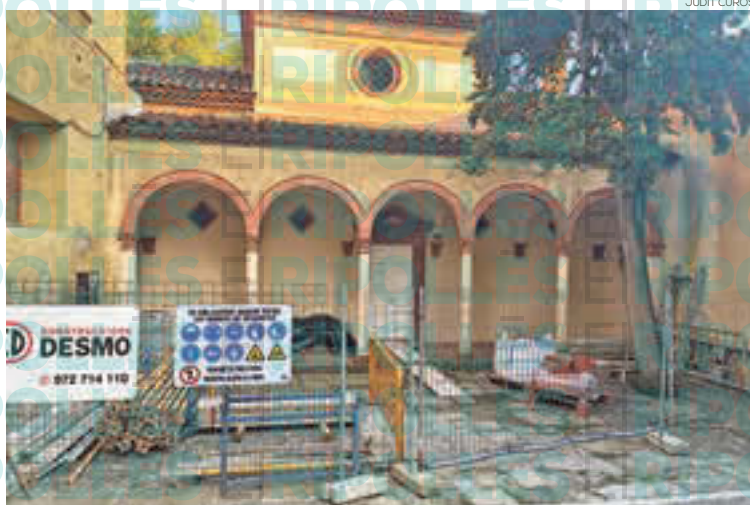
Estat actual de les actuacions a l'edifici de Duran i Reynals
