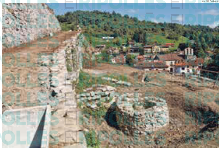
Obres de consolidació de les muralles dels jardins de Can Vincke
