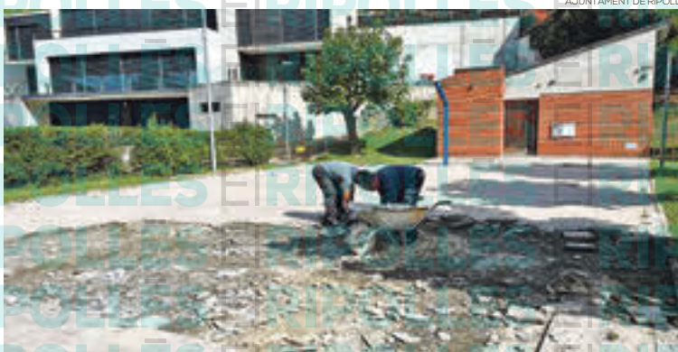
Els operaris treballen en la remodelació de l'espai
