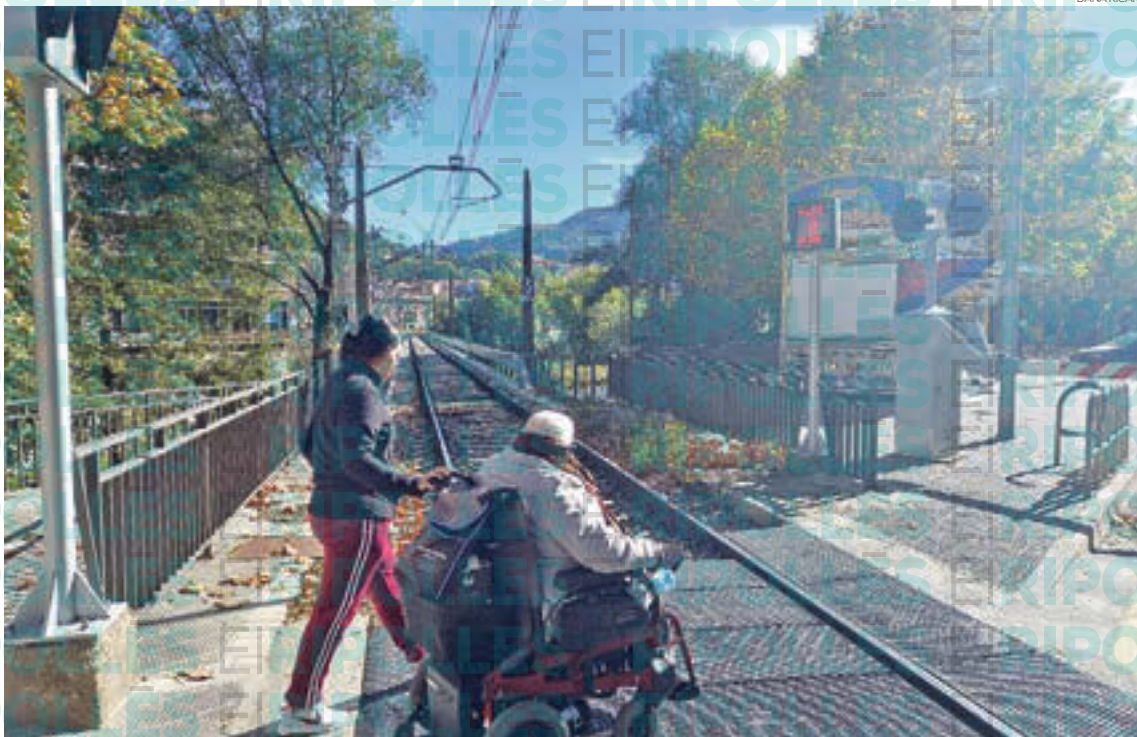
El pas a nivell de Ripoll es va avariar per segon cop en quinze dies provocant una situació perillosa pels vianants
