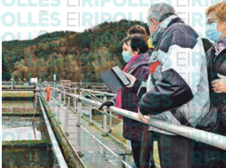
La visita a la depuradora de l'any passat
